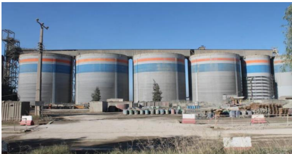
Figure 24 : silos de stockage du clinker, gypse et tuf.
