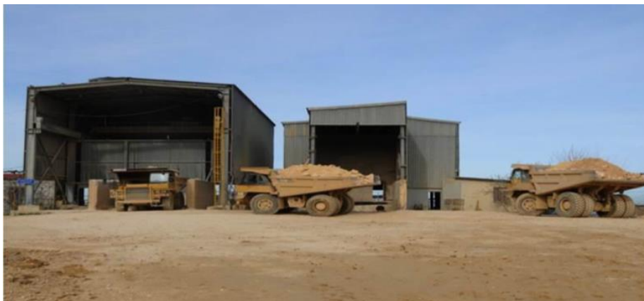
Figure 16 : transport et décharge de calcaire et argile
