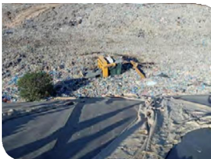
Photo 8 : Anomalie d'exploitation ; engin enfoui avec les DMA au niveau du casier.
