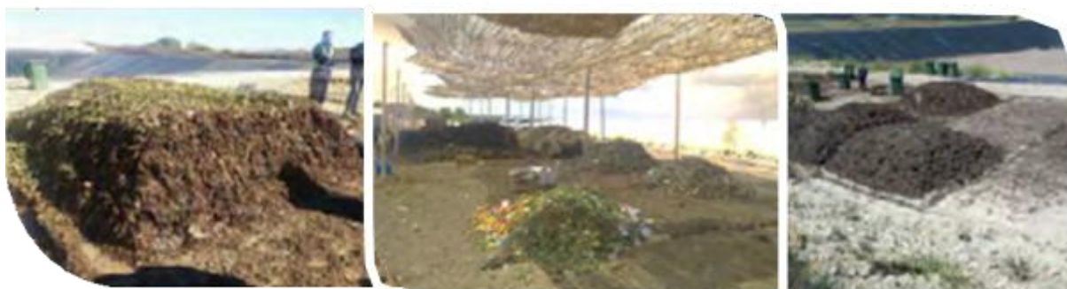
Photo 5 : Construction de plusieurs andains - Wilaya de Mostaganem et Sidi Bel Abbès.
