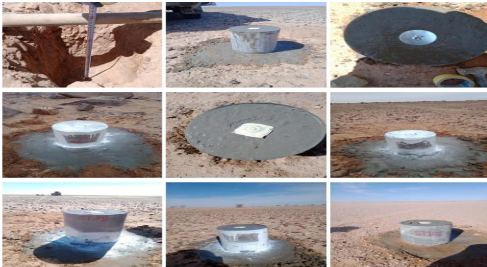
Figure N 15 : Réalisation de la polygonale secondaire (ST).
