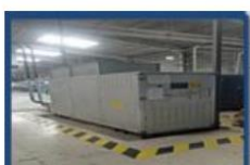
CHILLER 80 : utilitaire pour refroidissement d'eau
