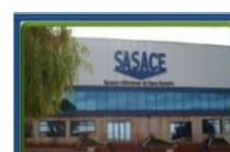
Batiment administratif et atelier
