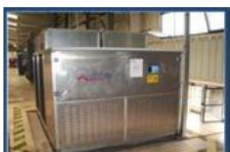
CHILLER 160 : utilitaire pour refroidissement d'eau
