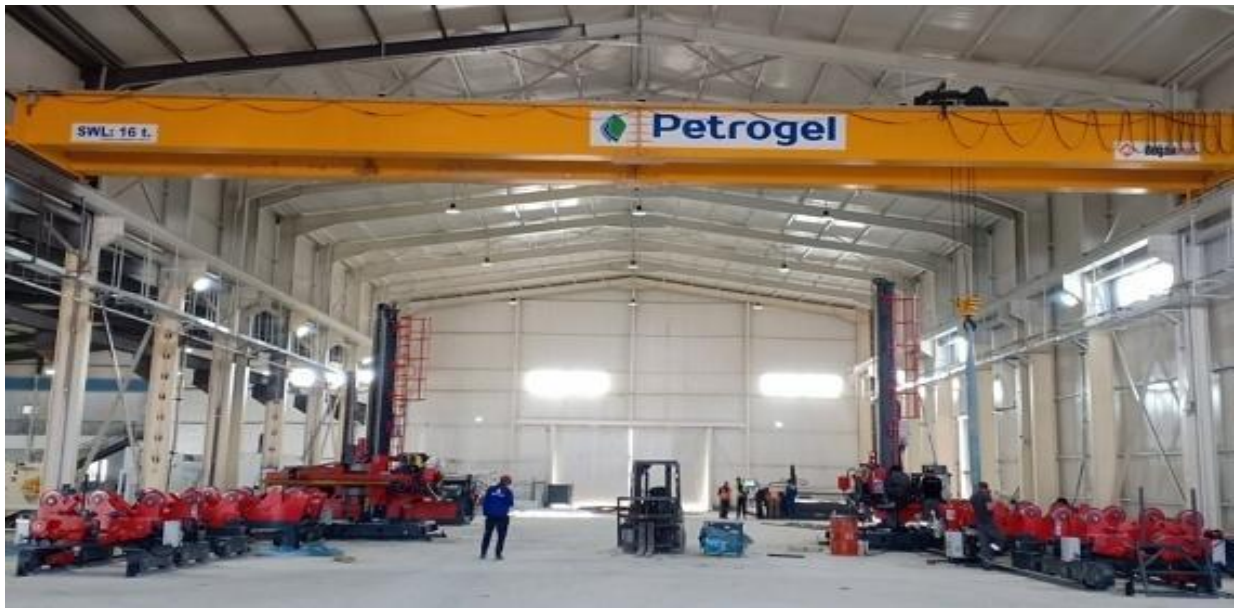
Figure 6 : Atelier de montage équipements pétroliers PETROGEL
