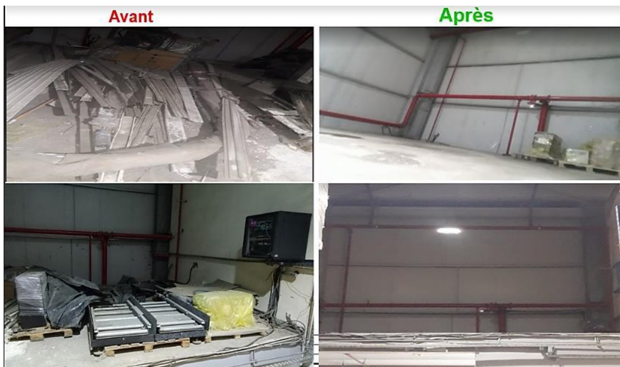
Figure 16 : Photo de la mezzanine avant et après le tri
