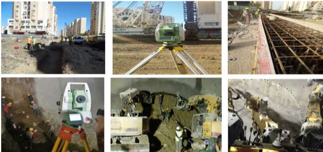
Figure 18: Des travaux topographiques du métro
