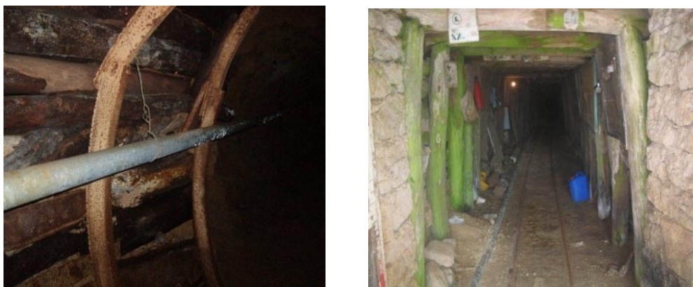
Figure 12: Travaux de soutènement
