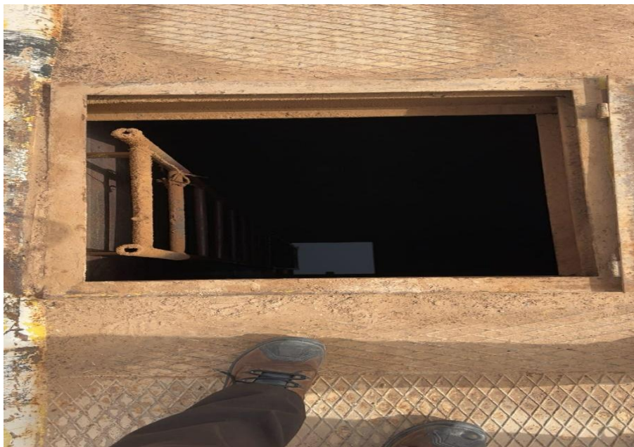
Figure 11: Bacs de stockage des fluides de forage
