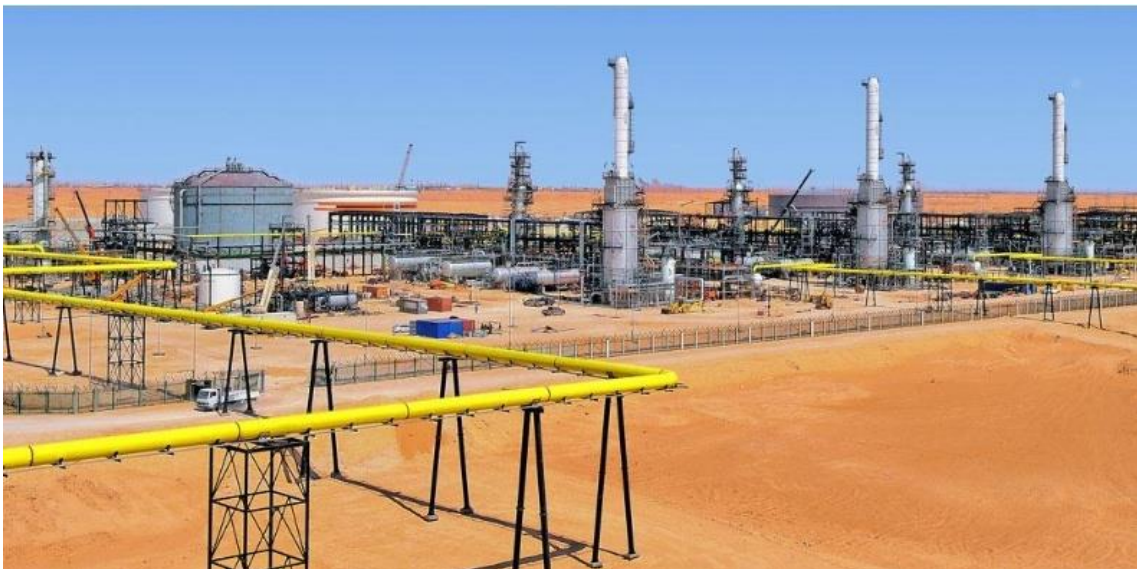
Figure 11 : Une vue générale de l'UTBS
