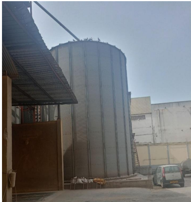
Figure 11 : Silos de stockage
