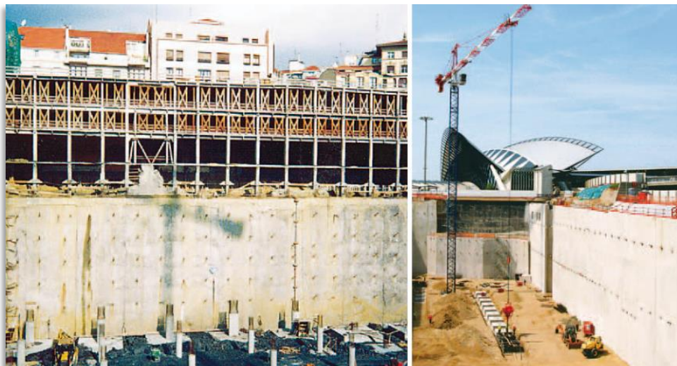
Figure 30 : Technique de soutènement par paroi moulée
